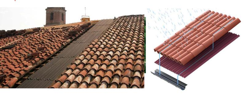
En France, la plupart des toitures sont recouvertes de tuiles différentes en fonction des régions (tuiles canal, tuiles plates ou mécaniques). Ce mode de couverture est apprécié pour sa fiabilité. Mais pour garantir une étanchéité pendant 30 ans, il doit être associé à un système de sous-toiture adapté.
