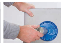
3 Passer le tuyau de raccordement (gaine électrique ou de télécommunication)
