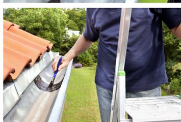
5/Une fois le géotextile posé, appliquez une seconde couche pour bien l'englober, en débordant d'environ 5 centimètres de chaque côté pour une protection optimale.
