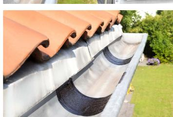
6/Pour finir, réalisez une troisième application sur l'ensemble de la gouttière, afin de créer un revêtement uniforme et durable. Laissez sécher au moins 24 heures avant toute mise en charge ou exposition à l'eau.
